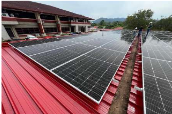
Pemasangan panel solar di bumbung bangunan di aset dan fasiliti FELDA dan FGV
