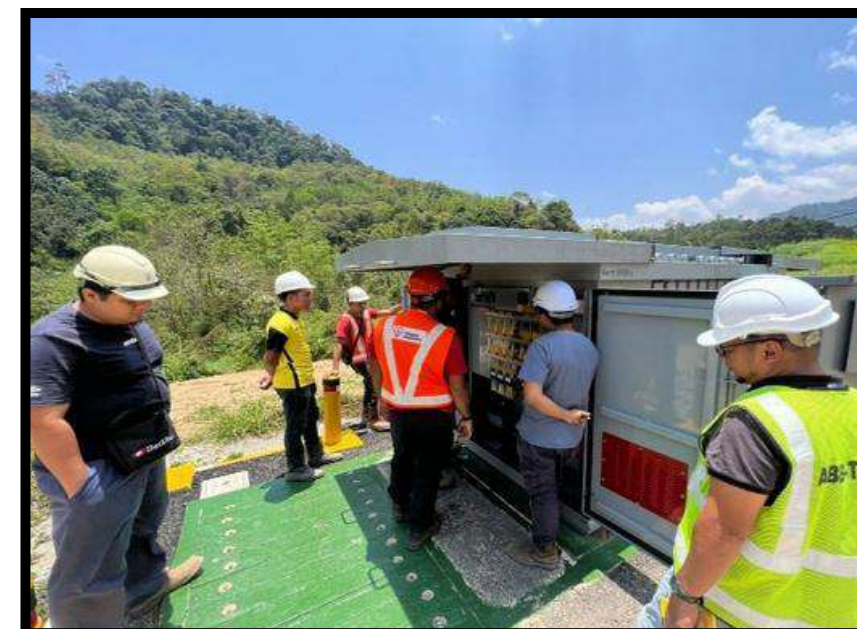
Kerja-kerja pembinaan talian grid dan pendawaian elektrik
