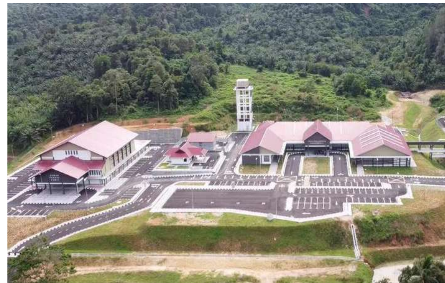
Orang Asli One Stop Centre (OAOSC) Bawong, Sungai Siput, Perak
