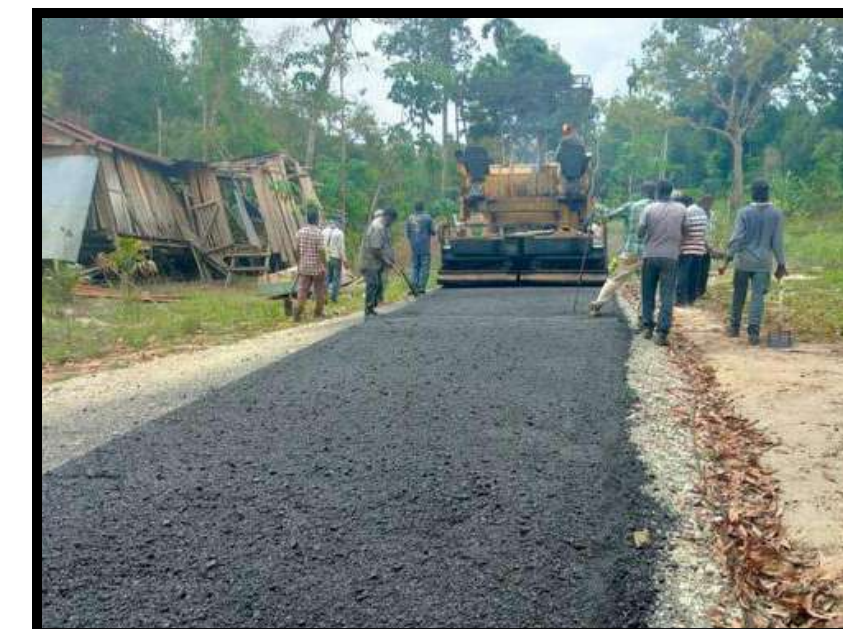
Kerja-kerja penurapan jalan perhubungan
